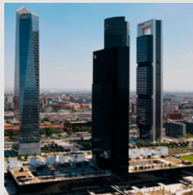
Torre Caleido (Madrid)
